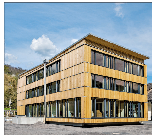
Die Firma Adams Holzbau-Fertigbau, Niederzissen, hat ihren neuen Stammsitz gleich selbst geschaffen – modern und nachhaltig. Foto: Dominik Ketz
